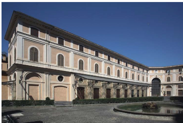
Veduta del lato breve del Fabbricato Cipolla
